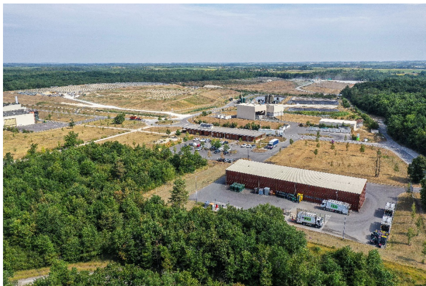
Vue aérienne du site de Sainte-Sévère
